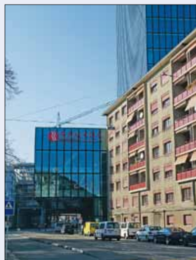
Fast 10 Jahre erfolgreich gerettet – jetzt droht den Rosenthalhäusern wieder der Abbruch.
